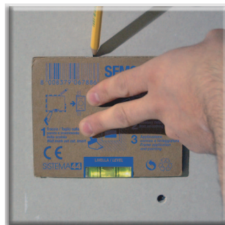
1 Pomoću libele nivelišite, pa iscrtajte šablon po zidu Use the level to fix the template then trace the line
