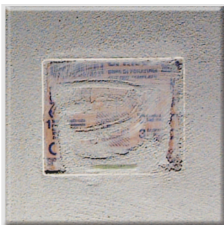
3 Poravnajte završni sloj maltera Make the finishing touches
