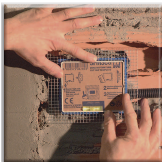
1 Napravite otvor u zidu i pomoću maltera pričvrstite kutiju u horizontalnom položaju, koristeći za nivelisanje priloženu libelu Make the hole and use the supplied level to fix the box
