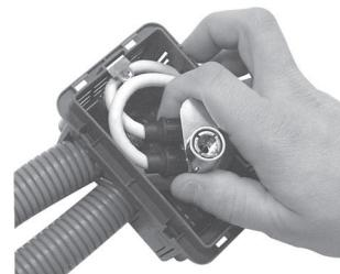
3. Introduire le dérivateur à travers le connecteur F mâle rapide sur le connecteur F Femelle de la prise TV/SAT déjà accrochée à l'armature.
